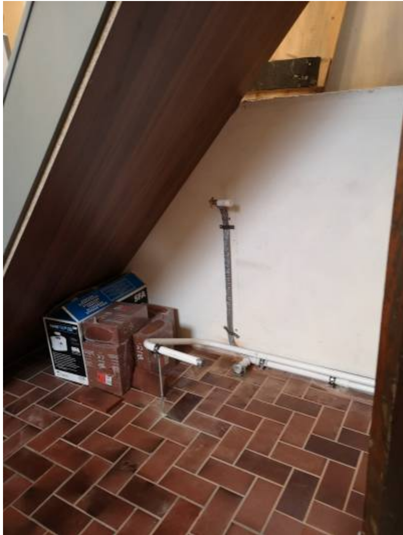
Mitte Februar: WC im Rohbau.
