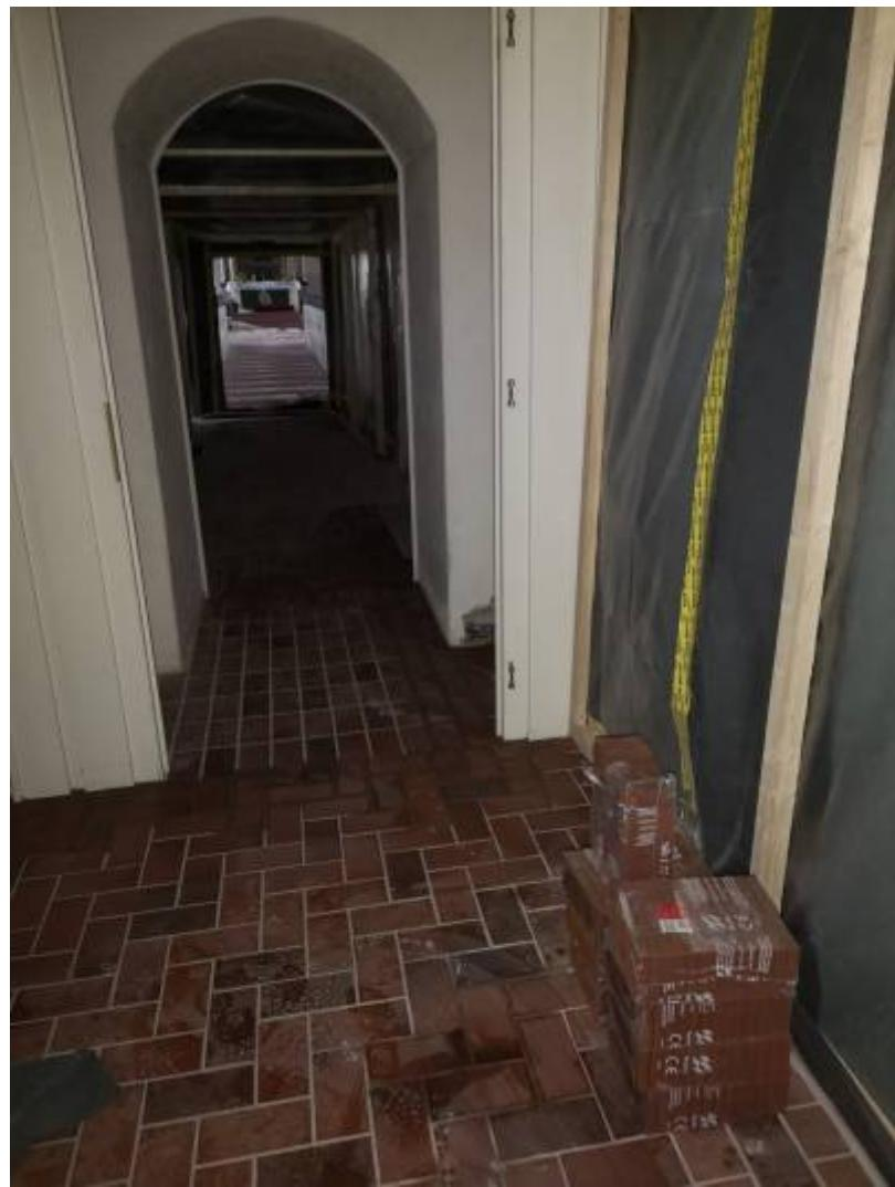
5. Februar abends: Die ersten Fliesen im Kirchenschiff sind verlegt, auch der Rahmen für den Revisionsschacht zum Luftkanal ist schon eingebaut.
