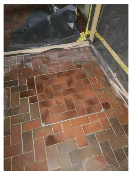
5. Februar abends: Die ersten Fliesen im Kirchenschiff sind verlegt, auch der Rahmen für den Revisionsschacht zum Luftkanal ist schon eingebaut.
