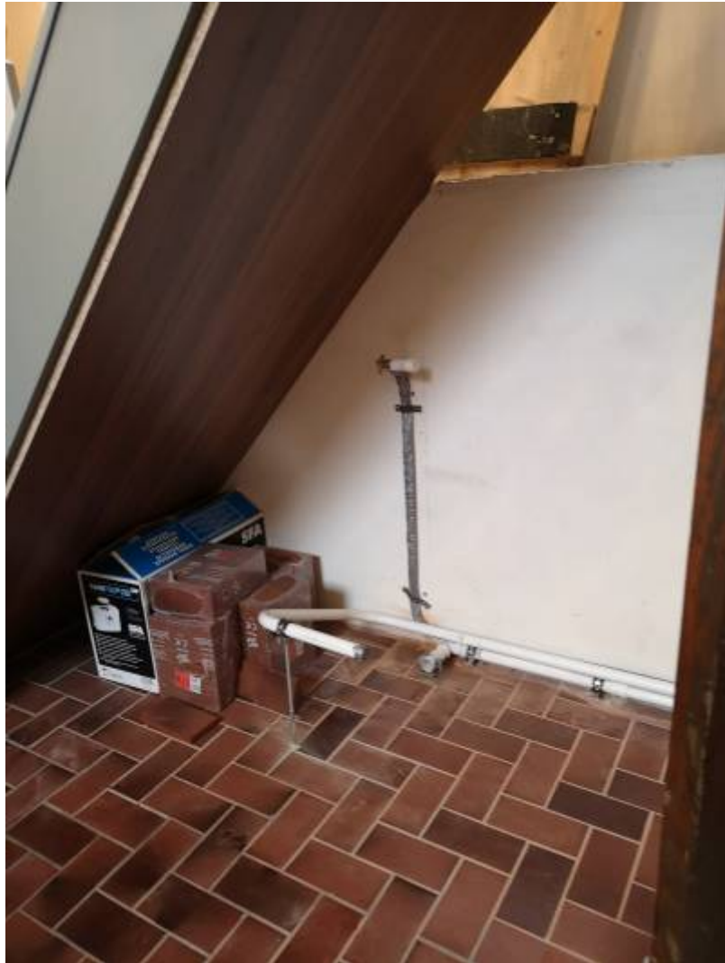
Mitte Februar: WC im Rohbau.
