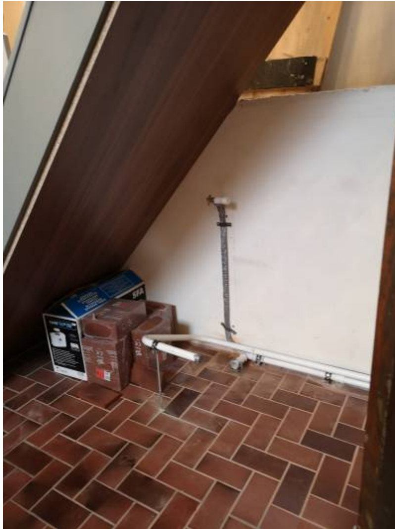
Mitte Februar: WC im Rohbau.
